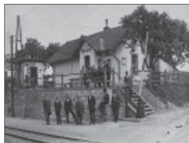
Železniční hradlo Troubsko
