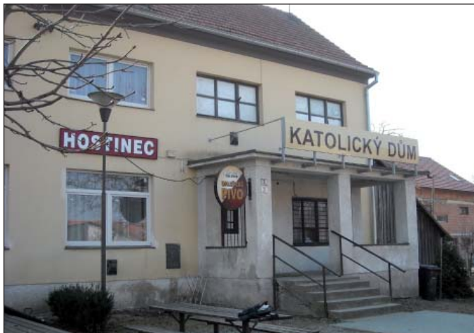
Pohled na Katolický dům
