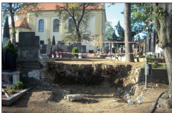
Opravy chodníku a schodiště
