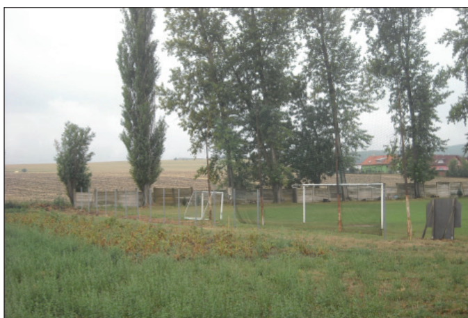
Začátek opravy plotu
