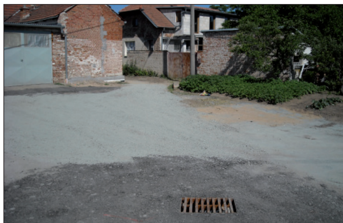
Přeložka dešťové kanalizace na ul. Školní
