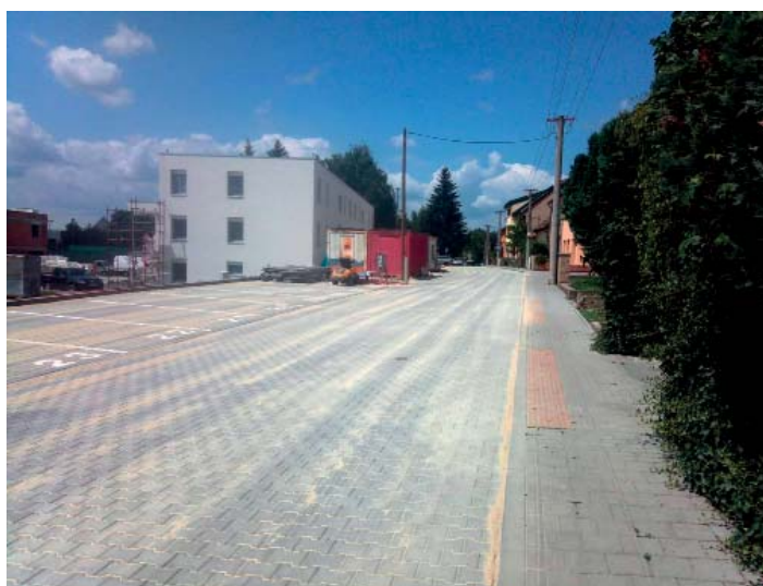
Oprava povrchu ulice U Rybníka
