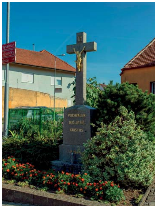
Oprava polního kříže ul. Zámecká
