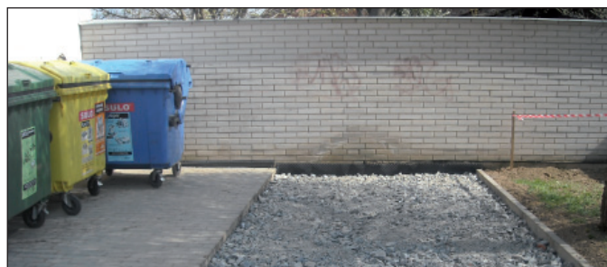
Hnízdo na ul. Zámecká (ve výstavbě)
