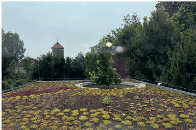
Zelená střecha budovy MŠ
