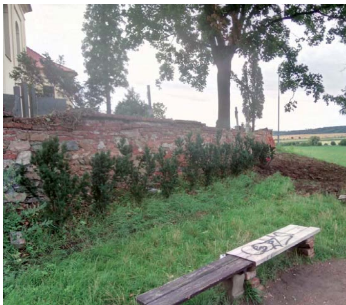
FOTO HISTORICKÉ ČÁSTI HŘBITOVNÍ ZDI PŘED REKONSTRUKCÍ
