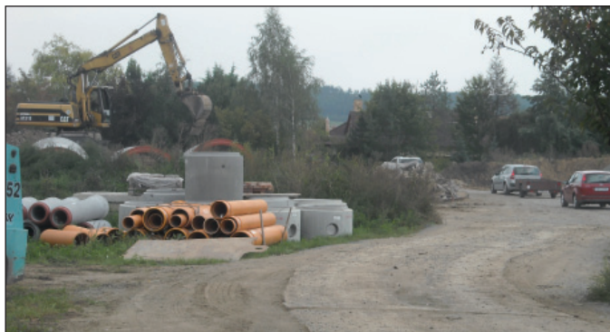
Výstavba IV. etapy kanalizace
