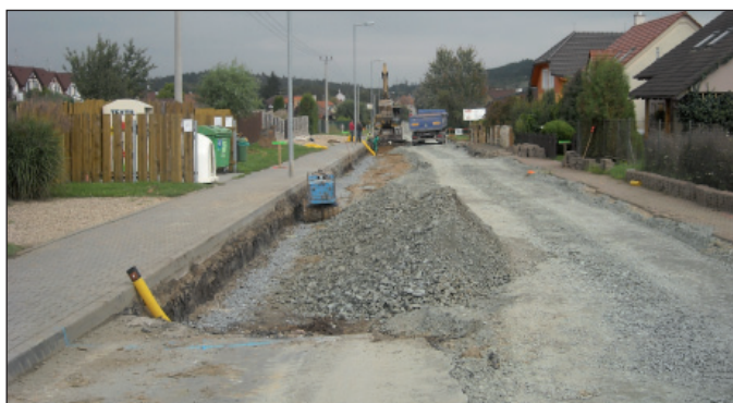
Rekonstrukce ul. Ostopovická
