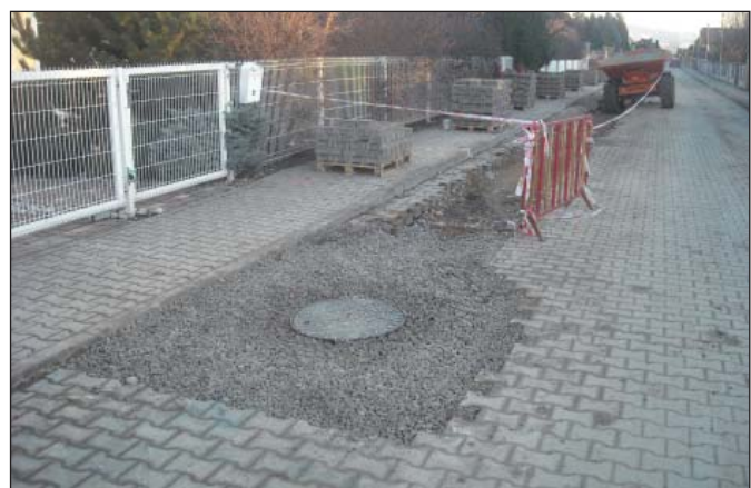
Výstavba kanalizace na ulici Sekorova
