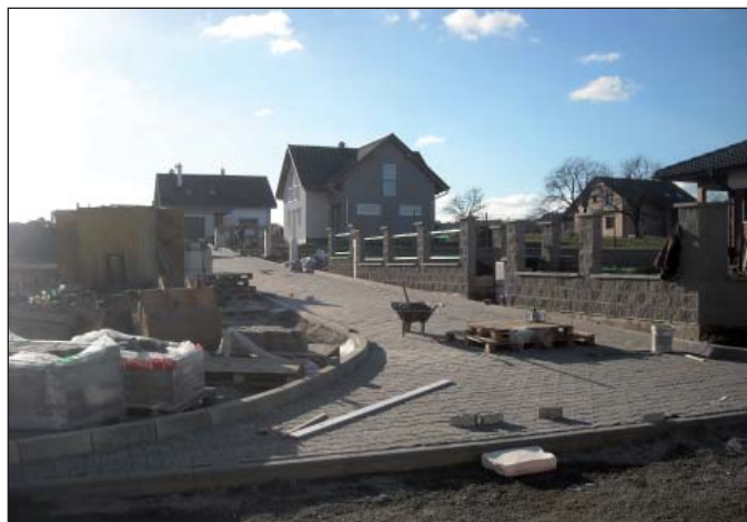
Výstavba na ulici Družstevní
