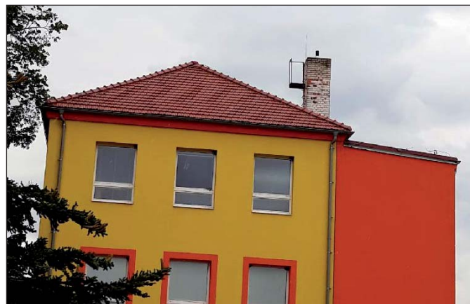
Nová střecha ZŠ
